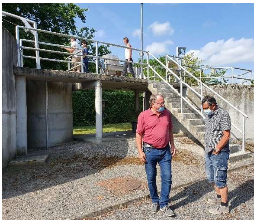
Station d'épuration de Saulzet
